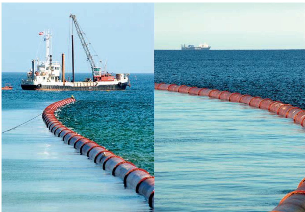
Fig. 5.11 och 5.12 Flottningen av en DN 1000 ledning [47] och dess avvinkling orsakad av strömmarna.
