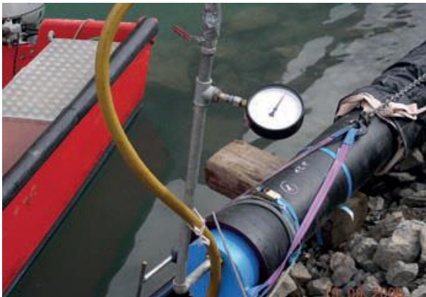
Fig. 5.6 Provtryckning av en DN 200 ledning
