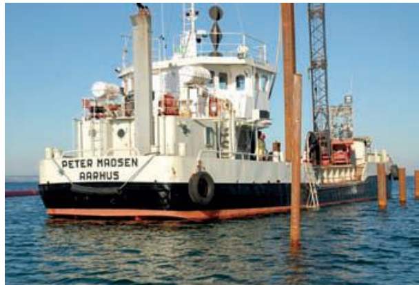
Fig. 5.10 Utläggning av pålar
