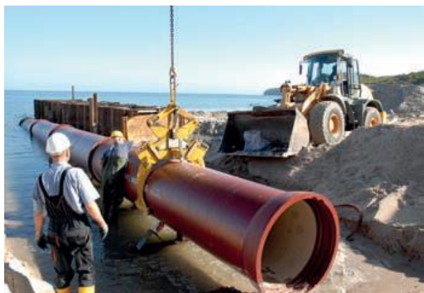
Fig. 5.3 rör-för-rör montering i Binz [47]
