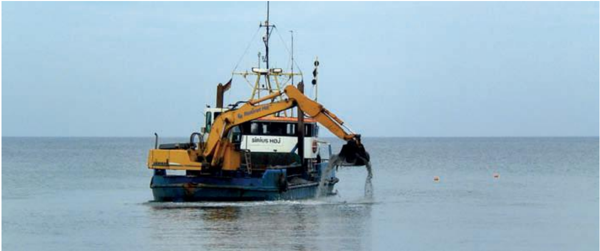
Fig. 5.5 Ett dike grävs ut under vattnet av ett mudderverk.
